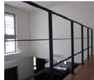
手すり スチール
